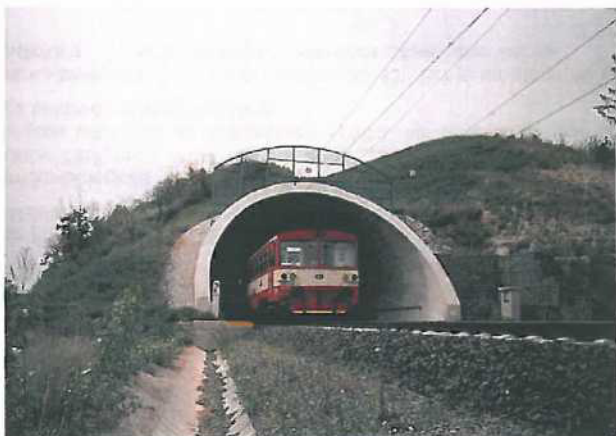
Tunel u Vepřku (směr Mlčechovosty), vybudovaný při rekonstrukci koridoru v roce 2002
