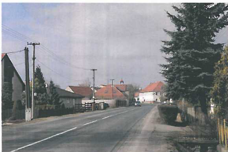
Silnice středem obce
