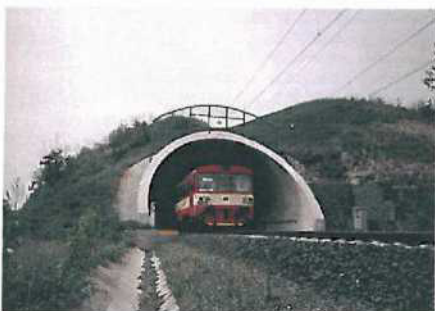
Tunel u Vepřku (směr Mířejovic), vybudovaný při rekonstrukci koridoru v roce 2002
