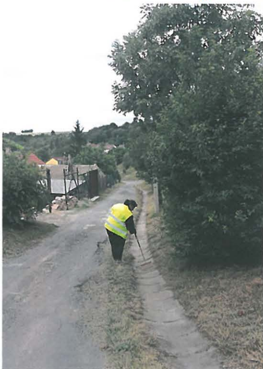
Čištění betonových žlábků
