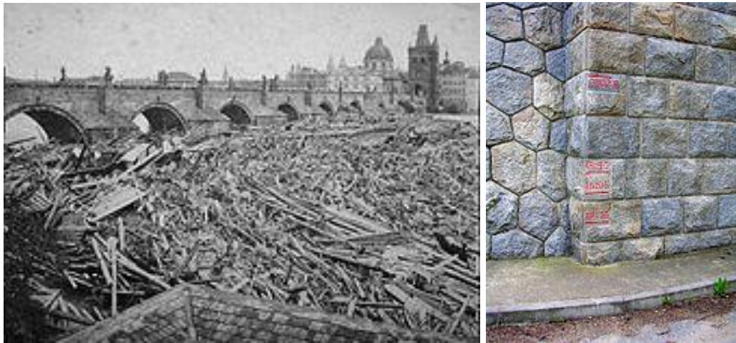
Karlův most v Praze při povodni v květnu 1872 / Značky vltavských povodní na železničním mostu ve Vepřku
