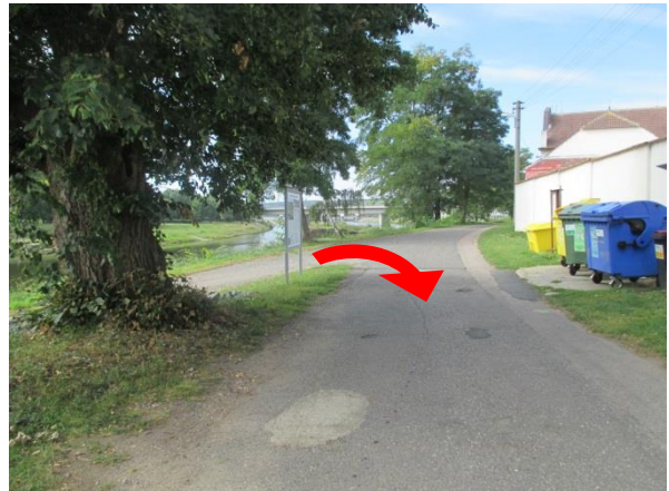
Obr. 7: Pohled na napojení sjezdu u zavázání hráze na místní komunikaci v Miřejovicích; z důvodu snížení nivelety komunikace zde bude docházet k obtoku hráze (při průtocích cca Q_{20} < Q < Q_{50} )
