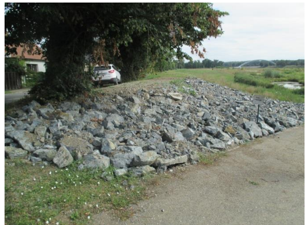
Obr. 5: Opevnění zavázání hráze kamenným záhozem u sjezdu z místní komunikace do inundačního území (08/2016)
