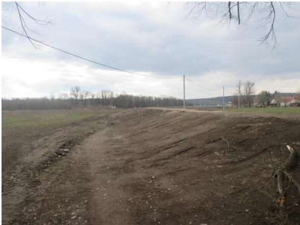
Obr. 6: Rekonstruovaná selská hráz v obecní části Miřejovice (02/2016)
