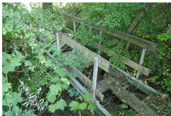
Lávka k energovodu
