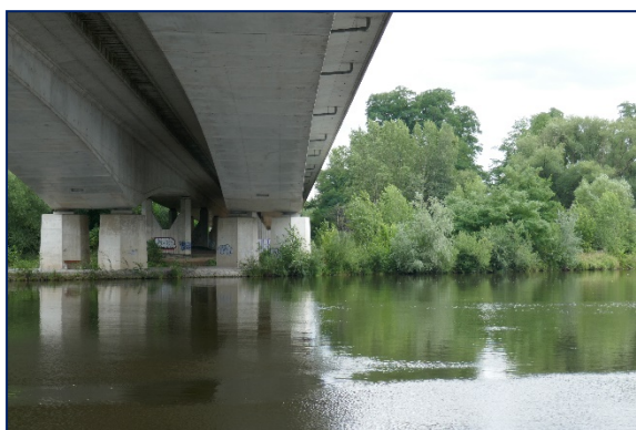
Návodní strana mostu
