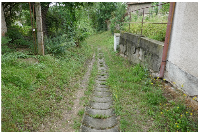
Jedna ze svodnic odvádějící dešťovou vodu ve svažité části obce, od návse
