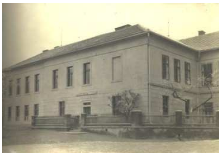
Škola po přístavbě.
