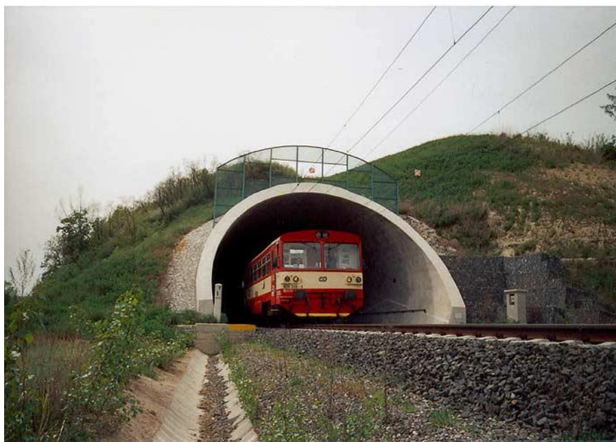
Tunel u Vepřku (směr Mlčechvosty), vybudovaný při rekonstrukci koridoru v roce 2002
