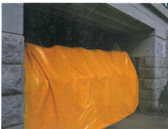
Foto 3: Vybudovaná hráz (pohled z nechráněné části)
