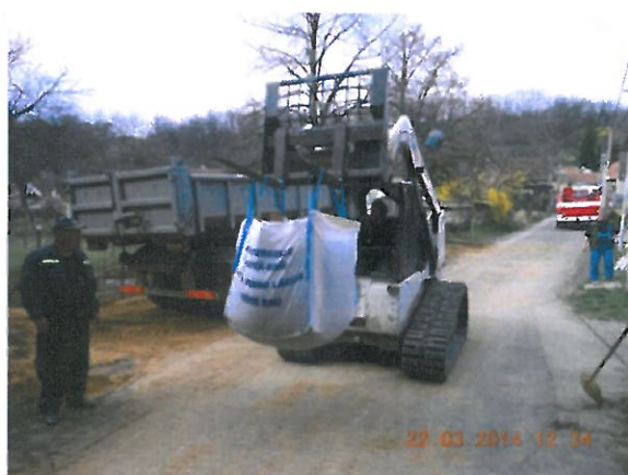
Foto 6: Demontáž hráze
