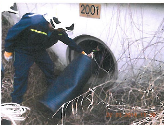
Foto 4: Zahrazování propustku vakem U50/100
