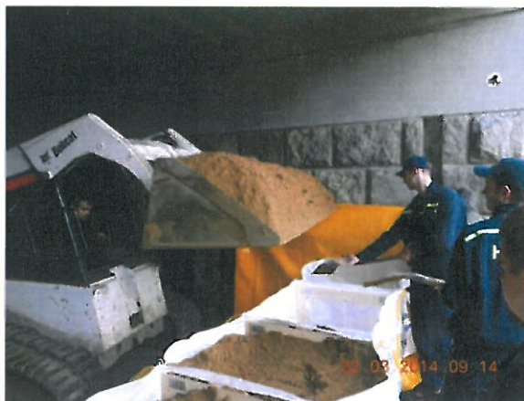
Foto 2: Plnění bagů jílovitým pískem
