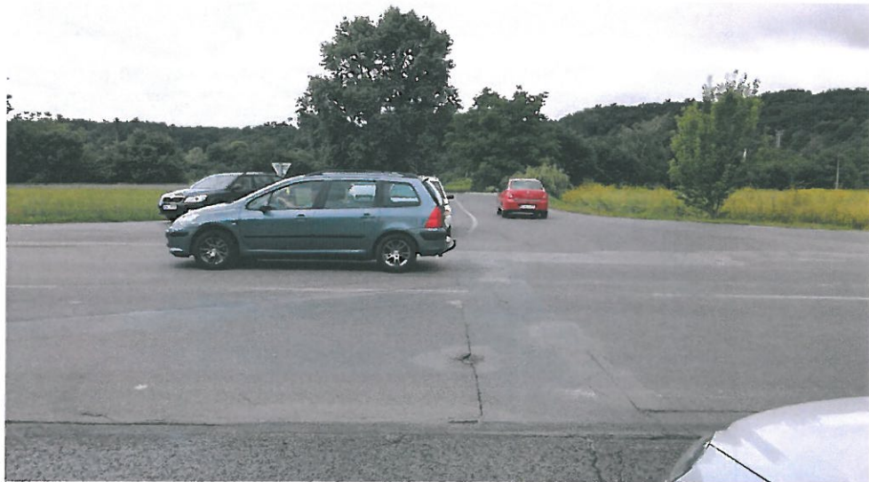
Příčné trhliny
